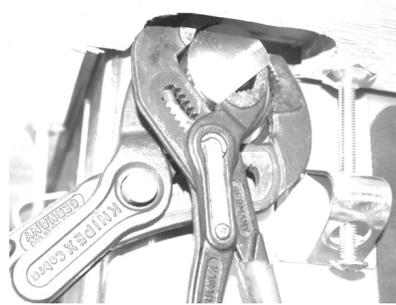
Die 2. Zange bitte unbedingt so ansetzen dass die Gewindeeingänge nicht beschädigt werden, sonst hast du nachher Schwierigkeiten die Flexschläuche zu montieren und dicht zu bekommen!
